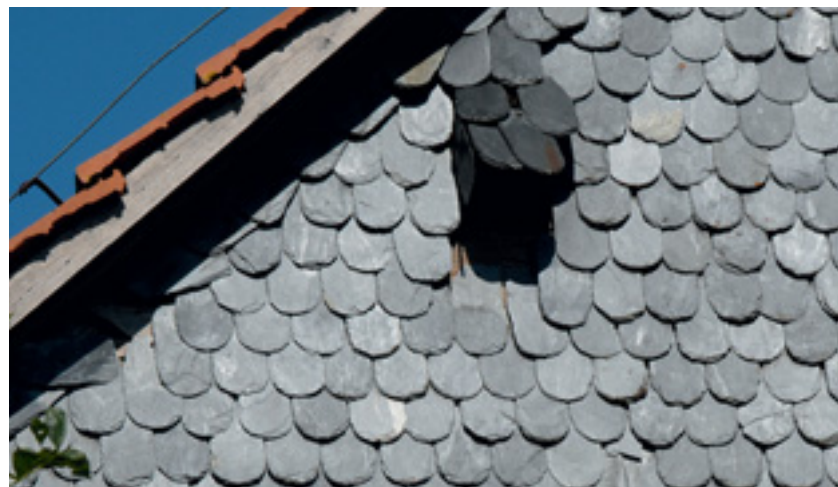
Détail d'une chape d'ardoises, à Brenles
