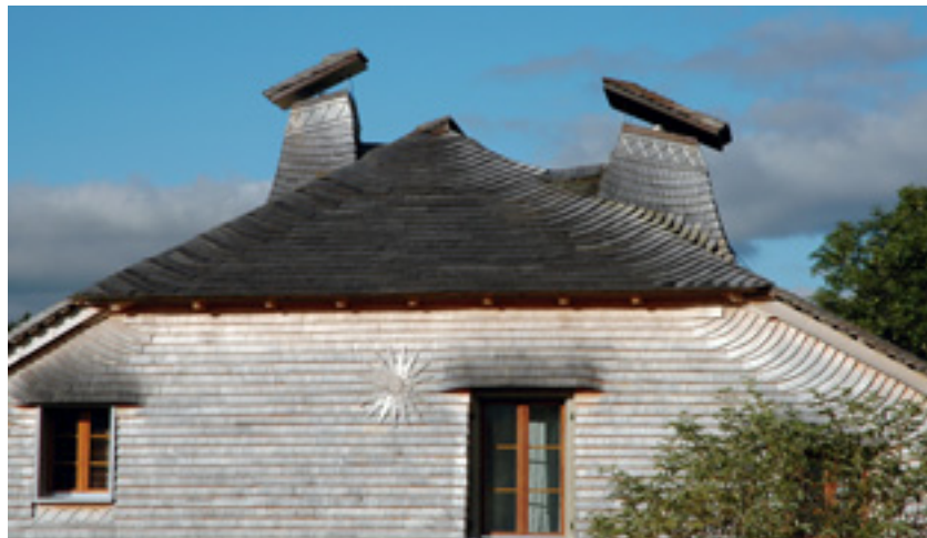
Toiture et cheminée en tavillons au Recorbet, à Vaullion
