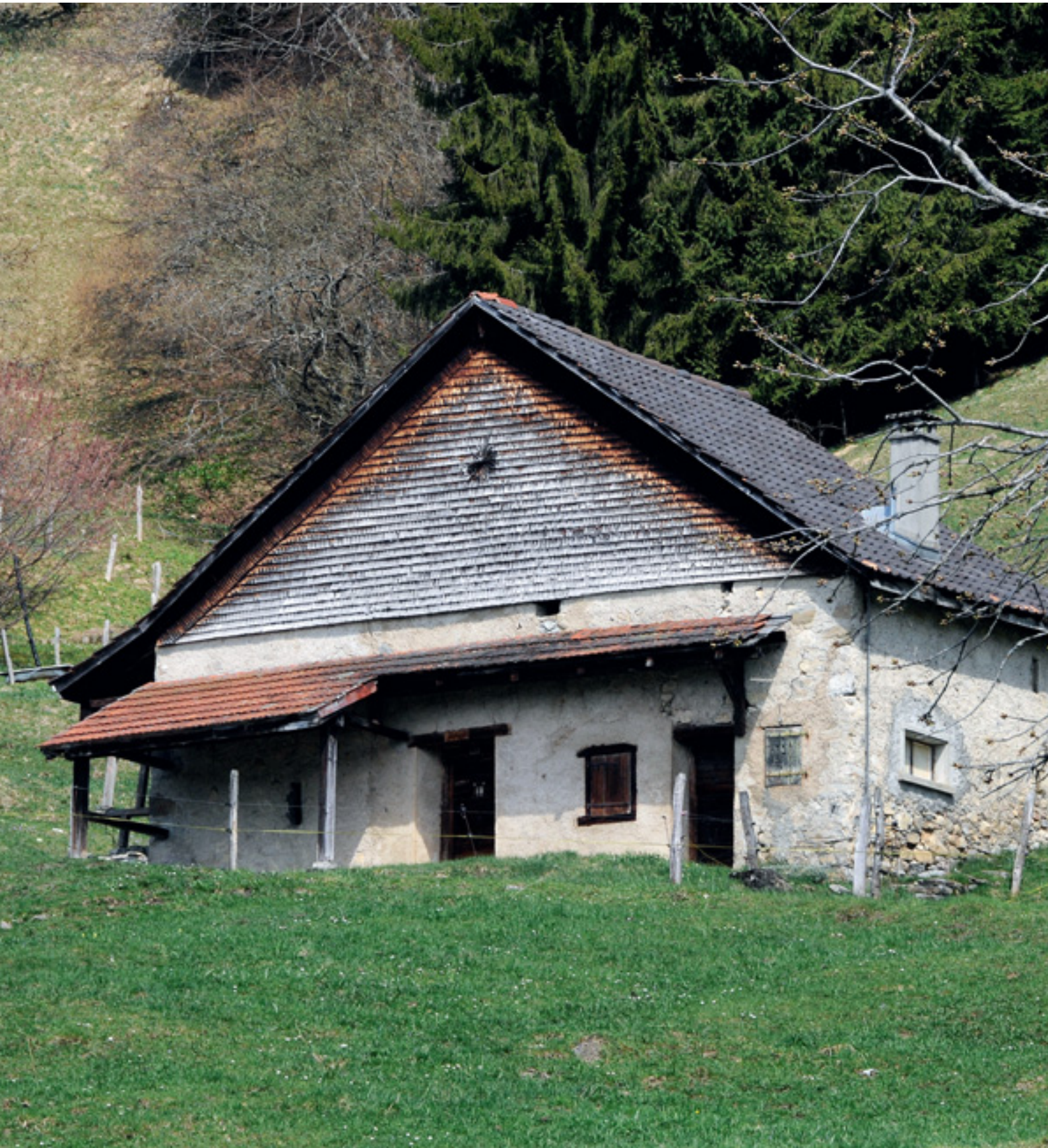
Loge à bétail, aux Vurzys (Villard-sur-Chamby)
