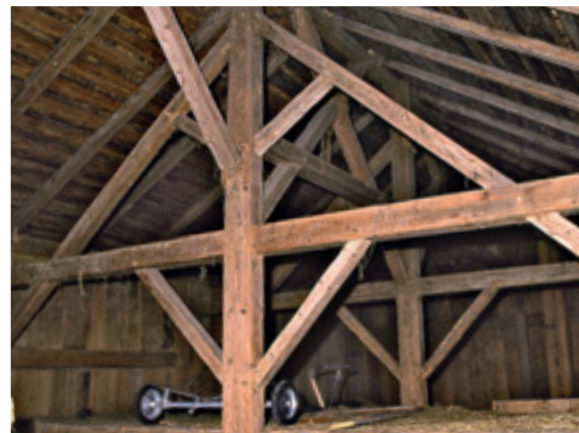
Charpente à poteaux au Mollard-sur-le-Brassus
