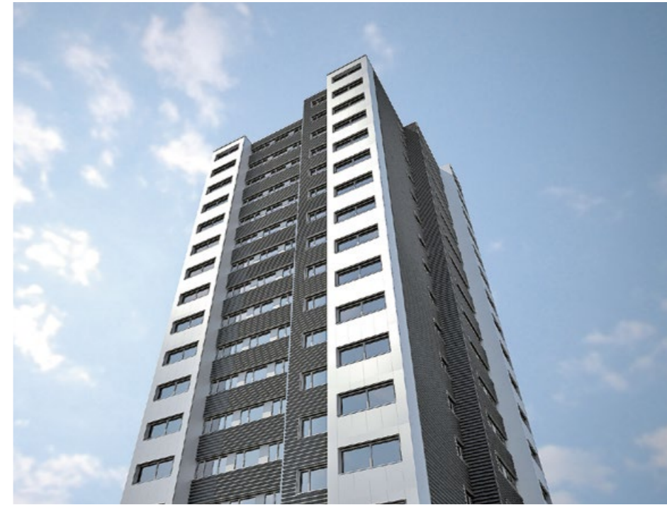
L'immeuble d'habitations de Malley 12 à Lausanne a récemment fait l'objet d'une rénovation en profondeur.
