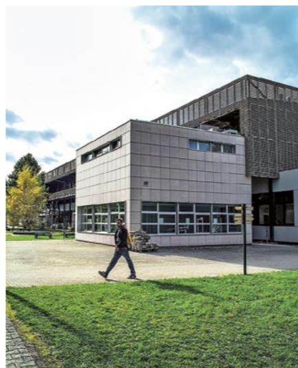
L'isolation des bâtiments a été entièrement refaite et permet de meilleurs rendements énergétiques.
