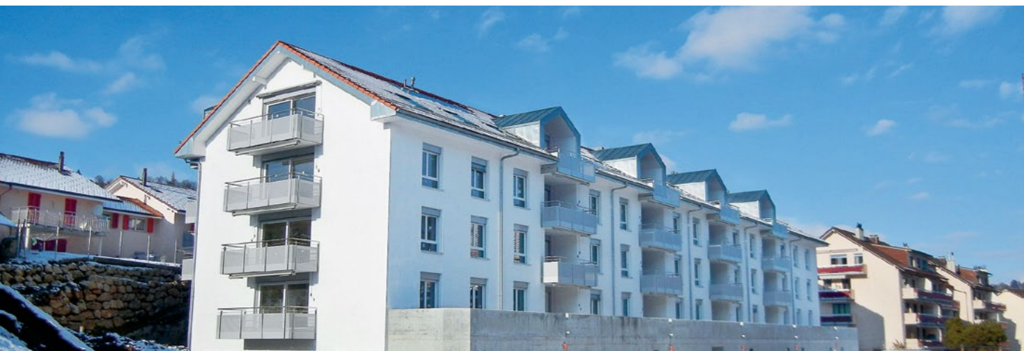
Le projet immobilier du Clos-du-Verger lors de sa construction en 2012.
